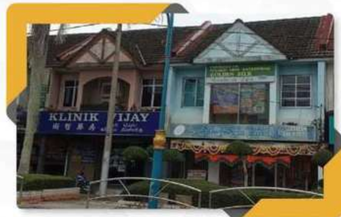
Kerja-Kerja Naik Taraf Feeder Pillar Single Phase Ke Three Phase Dan Pemasangan 3 Unit Lampu Hiasan Di Jalan Shahbandar Dan Di Jalan Maharaja Parit Buntar (Peruntukan MARRIS)
