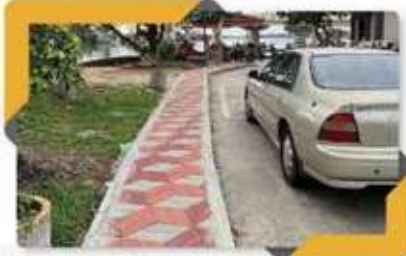
Kerja Membaiki Longkang, Tembok Penahan Dan Pejalan Kaki Di Jalan Swee Lee Kuala Kurau, (Peruntukan Persekutuan BP.1)
