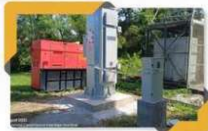
Binaan menara telekomunikasi di atas rizab jalan di Kampung Keramat, Bagan Serai
