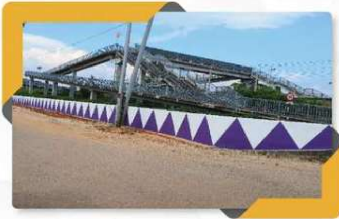
Membina Tembok Dinding Di Sistem Saliran Utama Di Lorong Belakang Jalan Maharaja Parit Buntar (Peruntukan JPS Negeri Perak)
