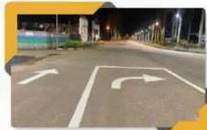
Kerja Penyelenggaraan Garisan Jalan Di Parit Buntar 2 (MD Kerian)
