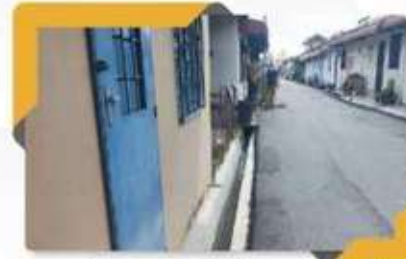
Menyelenggara Longkang Dan Jalan Di Lorong Belakang Jalan Serai Permai 8 Taman Serai Permai, Bagan Serai (MARRIS)
